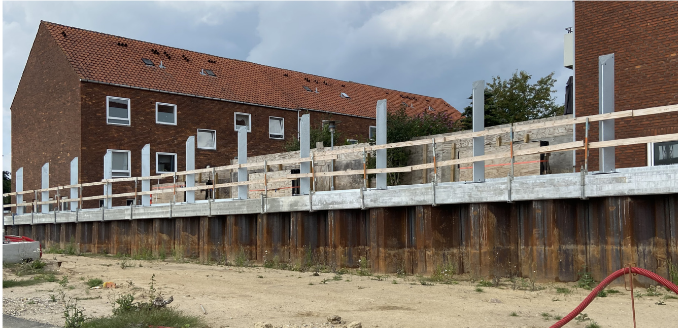
Ny støttemur og støjskærm under opførelse
