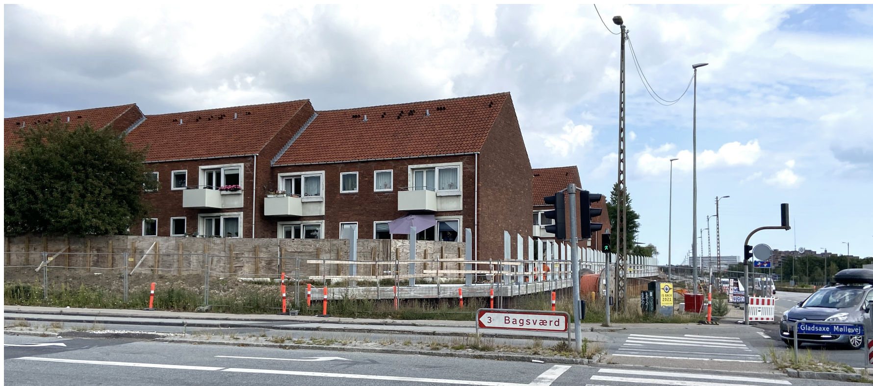
Ny støttemur og støjskærm under opførelse ved hjørnet af Gladsaxe Ringvej og Gladsaxe Møllevej
